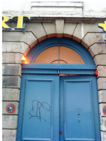
Figure 3b. Porte cochère de l'immeuble où habitait L Ollier, 3 quai Gaillon à Lyon.
